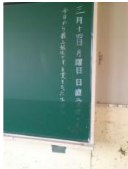
2年1組の黒板には、3日後月曜日の日付と最上級生の目標が。その真ん中に津波の跡。
